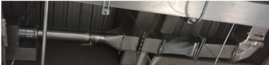
VAV安装接管示意图
