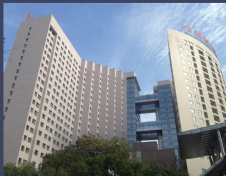
融为整体的新老建筑
